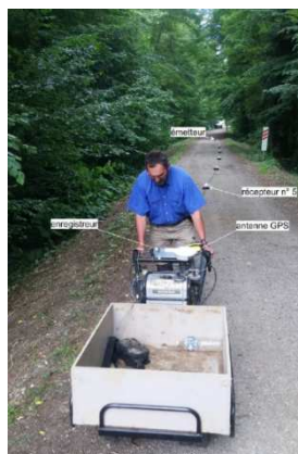
Auscultation d'une digue par le BRGM (©BRGM)
