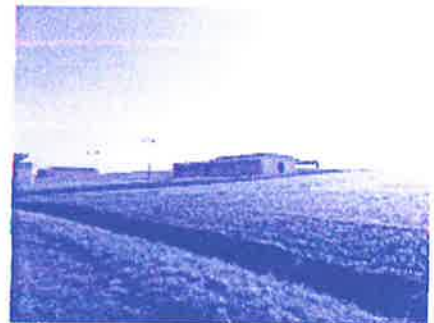
CENTRE SOCIO-CULTUREL ET HANGARS AU SUD DU VILLAGE DE CHIEULLES
